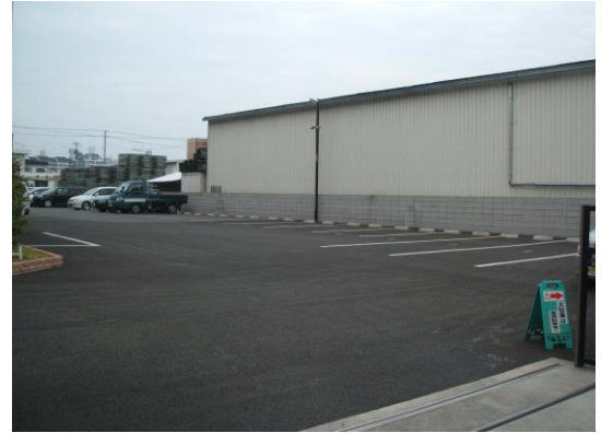
開粒度アスファルトの駐車場
