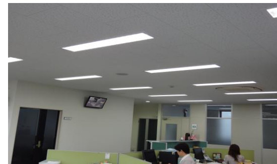
事務室のLED照明
